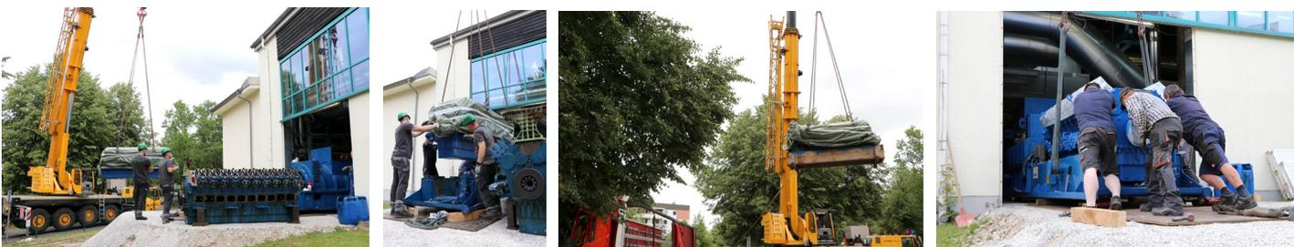
Bild 1: Der neue Motorblock wird mit Hilfe des Krans zum Grundrahmen des BHKW transportiert.
