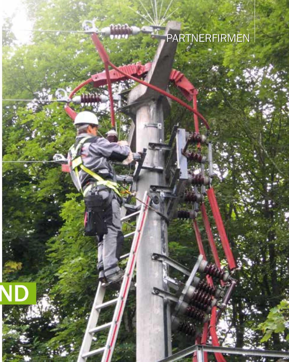
Reyk Schaarschmidt bei Revisionsarbeiten an der Masttrafostation.
