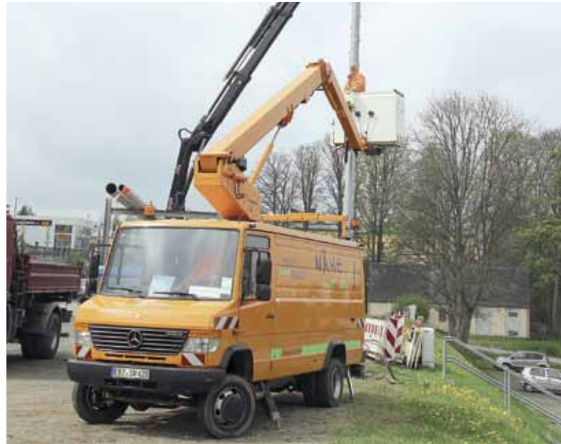
Stadtwerkemitarbeiter beim Justieren der neuen Masten.
