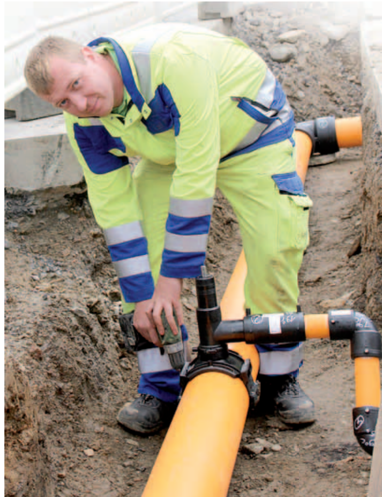
Eine aufgespürte Störstelle in der Karlsbader Straße wurde sofort repariert. Im Bild Netzmonteur Axel Baumann.
