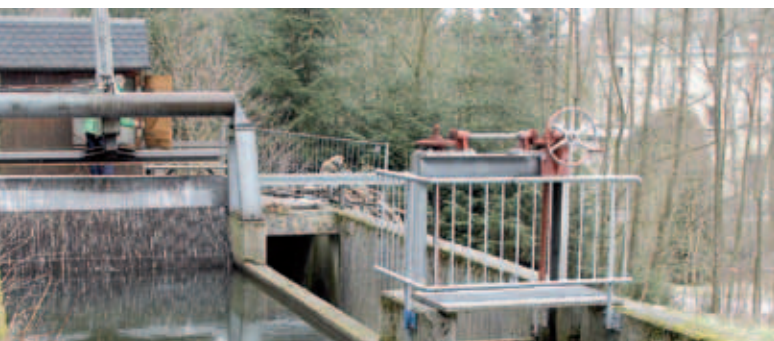
Die Stadtwerke Annaberg-Buchholz betreiben Wasserkraftanlagen an Zschopau und Pöhlbach.
