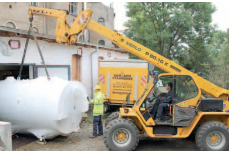
Millimeterarbeit: Einer der beiden Spitzenlastkessel wird ins Heizkraftwerk gehievt.
