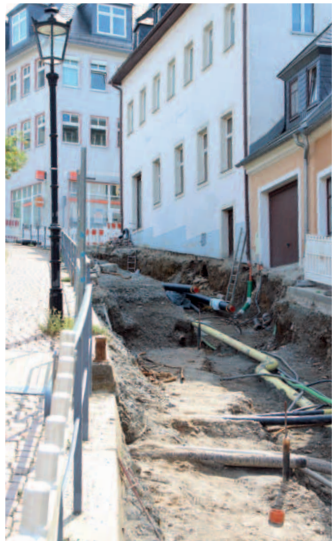
Die Frohnauer Gasse erhielt im Sommer dieses Jahres in ihrem oberen Teil Fernwärmeleitungen.
